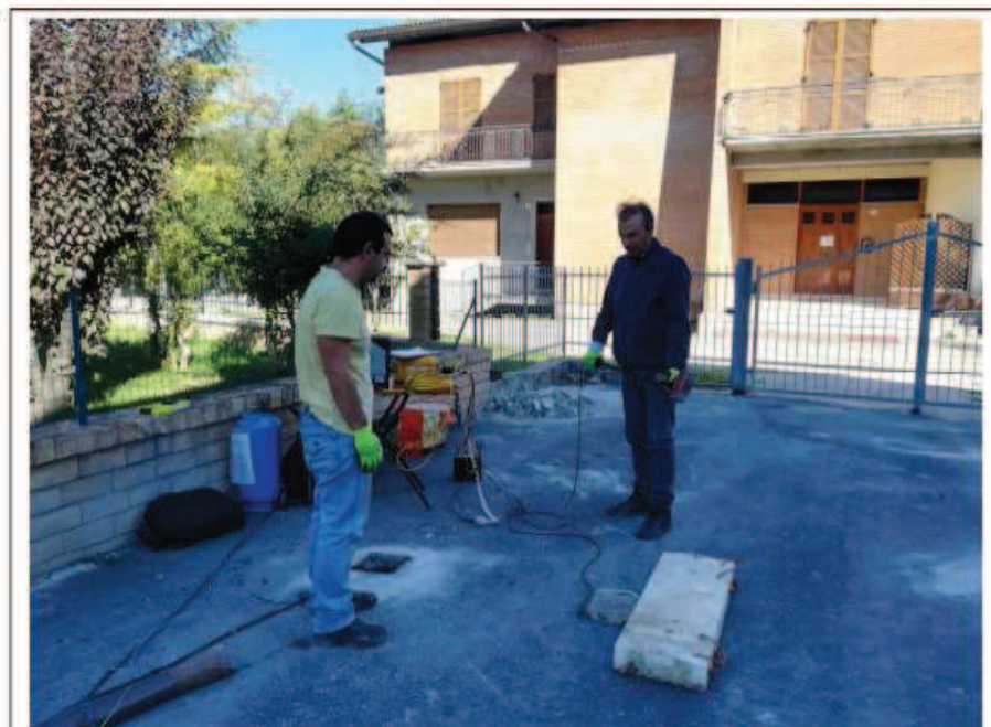
Foto - Sito di durante l'esecuzione della prova
